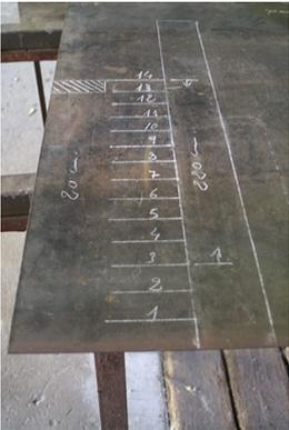
2. Desenhe um esboço na escala da elevação para verificar se em todos os momentos temos 220 cm entre os degraus sobrepostos.
