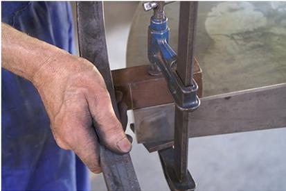
3. Se comprueba que la baranda encaja con las marcas del utillaje.
